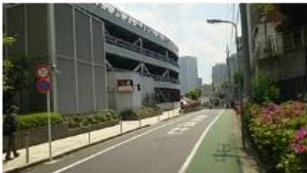
(4) 道なりに進むと、左側に駐車場、駐輪場が見える
